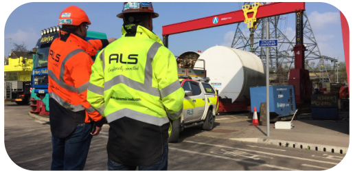
Gantry lift - 76T TBM - ALS on site project management
