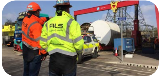
Gantry lift - 76T TBM - ALS on site project management
